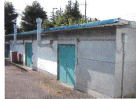
写真 危険物倉庫の外観
