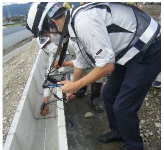
(使用例) 側溝出来型検査時の様子 コンベックスのメモリを精確に読み取れます
